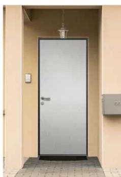
Réutilisable, l'ouvrant de chantier est à poser sur le dormant définitif. Il permet de ne pas endommager l'ouvrant final durant toute la durée du chantier.
