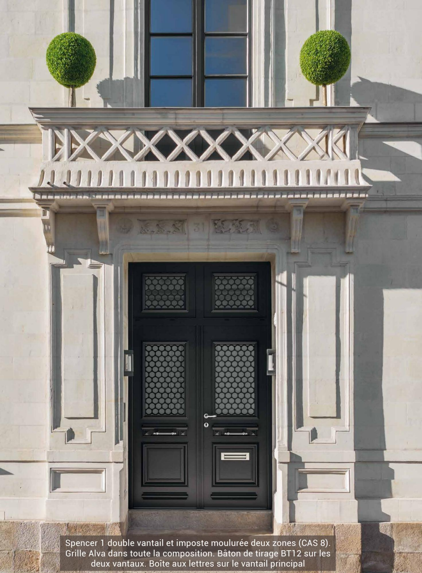
Spencer 1 double vantail et imposte moulurée deux zones (CAS 8). Grille Alva dans toute la composition. Bâton de tirage BT12 sur les deux vantaux. Boîte aux lettres sur le vantail principal
